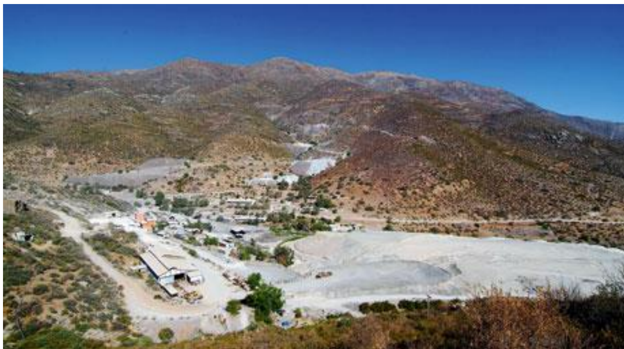
Fotografía 9: Vista de Mina el Bronce
